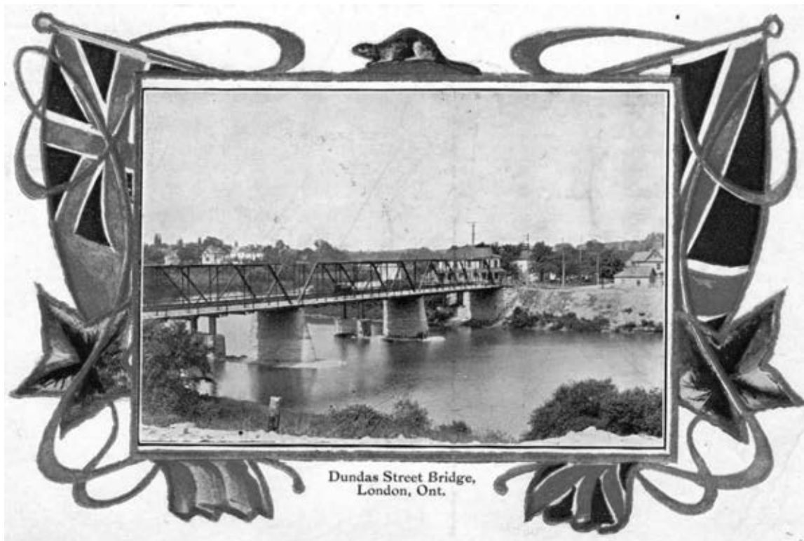
Dundas Street Bridge. A. Talbot & Co., London
